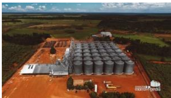
Figura 12: A Instalação de armazenamento do Grupo Morro da Pedra em Lagoa da Confusão
